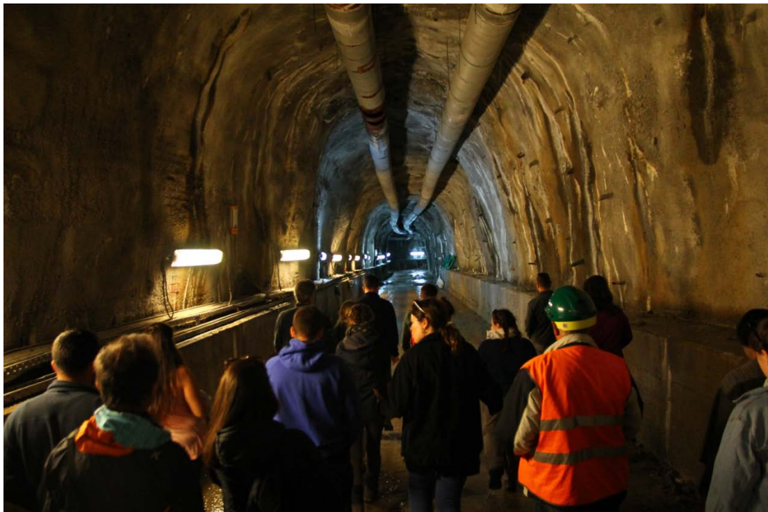
Εκπαιδευτική εκδρομή φράγμα Ευήνου σήραγγα προσπέλασης θαλάμου θυροφράγματος εκκένωσης.
